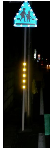
自発光式道路標識
