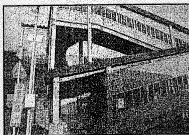
④岩崎 国道下からの歩道橋
