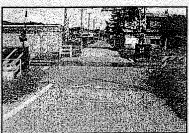
㉒旧商工入口からの杉沢踏切
