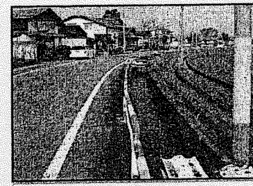
⑨八幡の道路沿い水路
