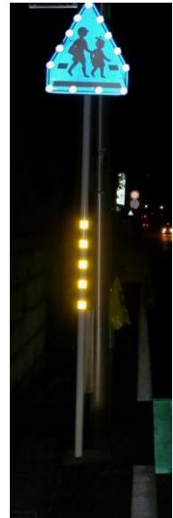
自発光式道路標識
