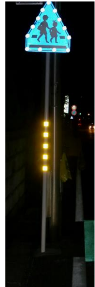
自発光式道路標識
