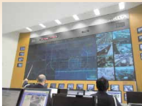
交通管制センター
