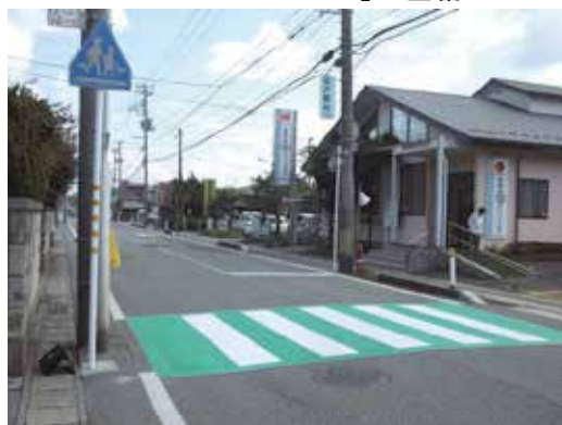
横断歩道のカラー舗装
